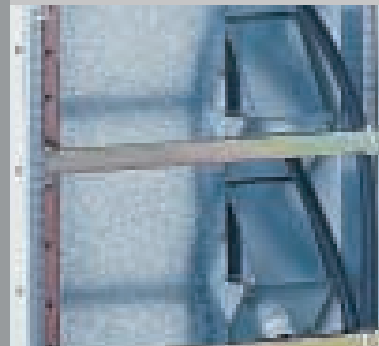
Rückseitiger Kabelanschlussraum mit cable gland box je Funktionseinheit, innere Unterteilung Form 4 Typ 7 entsprechend BS EN 60439
