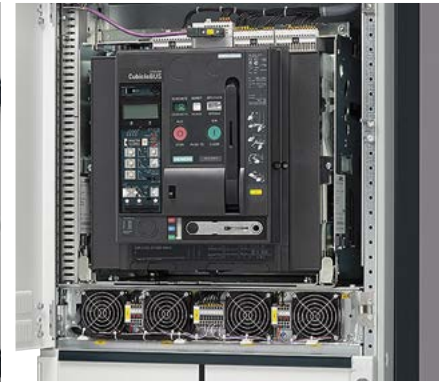
Kühlsystem mit Lüftern unterhalb des Leistungsschalters 3WL
